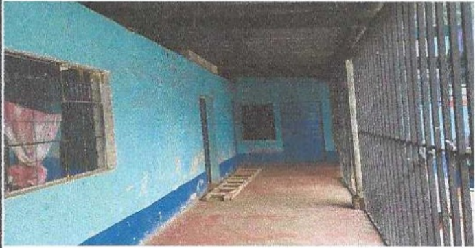
Foto 3: ampliacion de aula hasta donde esta la reja con muro de block.
