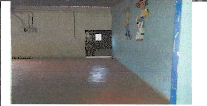
Foto 5: aula donde se va ampliar.
