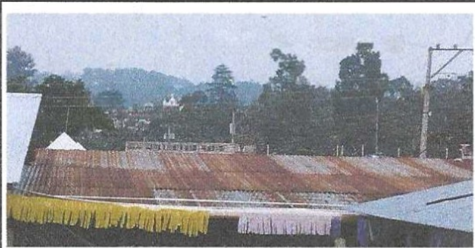
Foto1: Cambio de láminas por láminas troqueladas y caída a dos agua.
