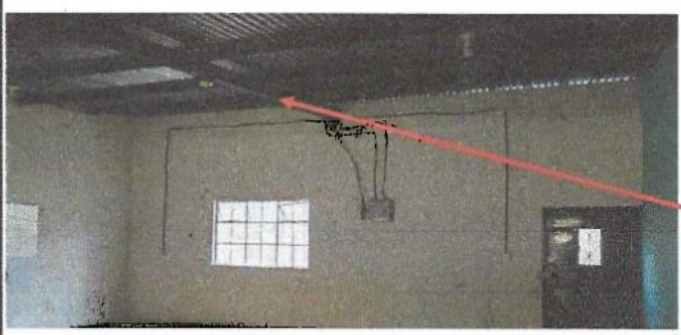
Foto 6: Cambio de estructura de techo, material de metal por metal.
