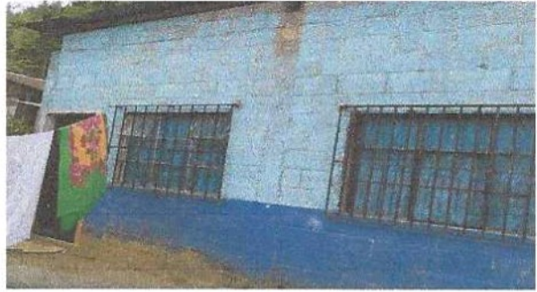
Foto 2: Cambio de estructura de ventanales y ampliar.
